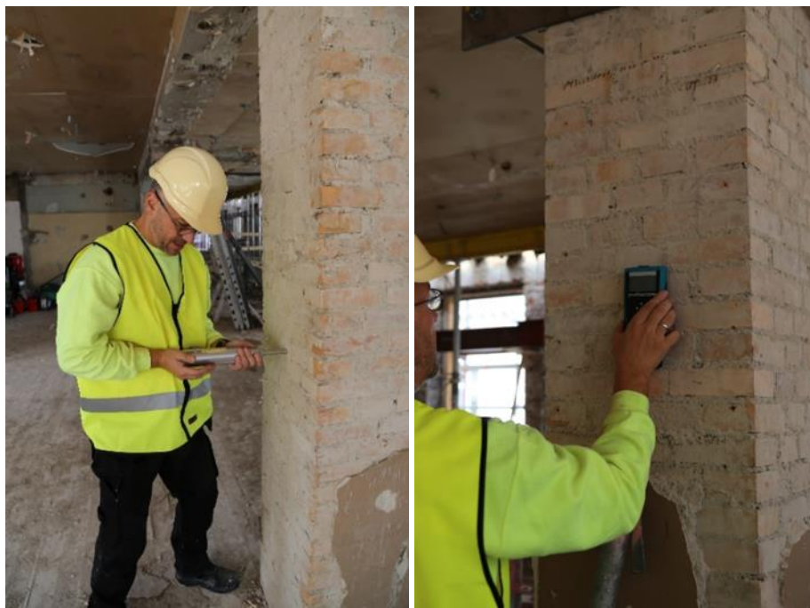
Figur 12 Dimitrios Boubitsas från RISE inspekterar tegelpelares skick med hjälp av icke-förstörande provning. Till vänster studshammare, till höger täktskiktsmätare.
