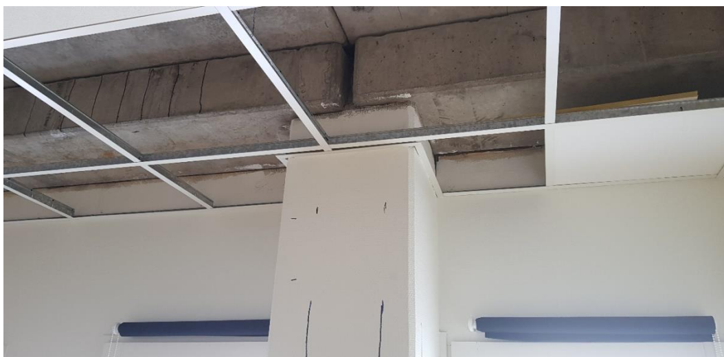
Figur 43 Utformning av upplag för balk ovanför pelartoppen.
