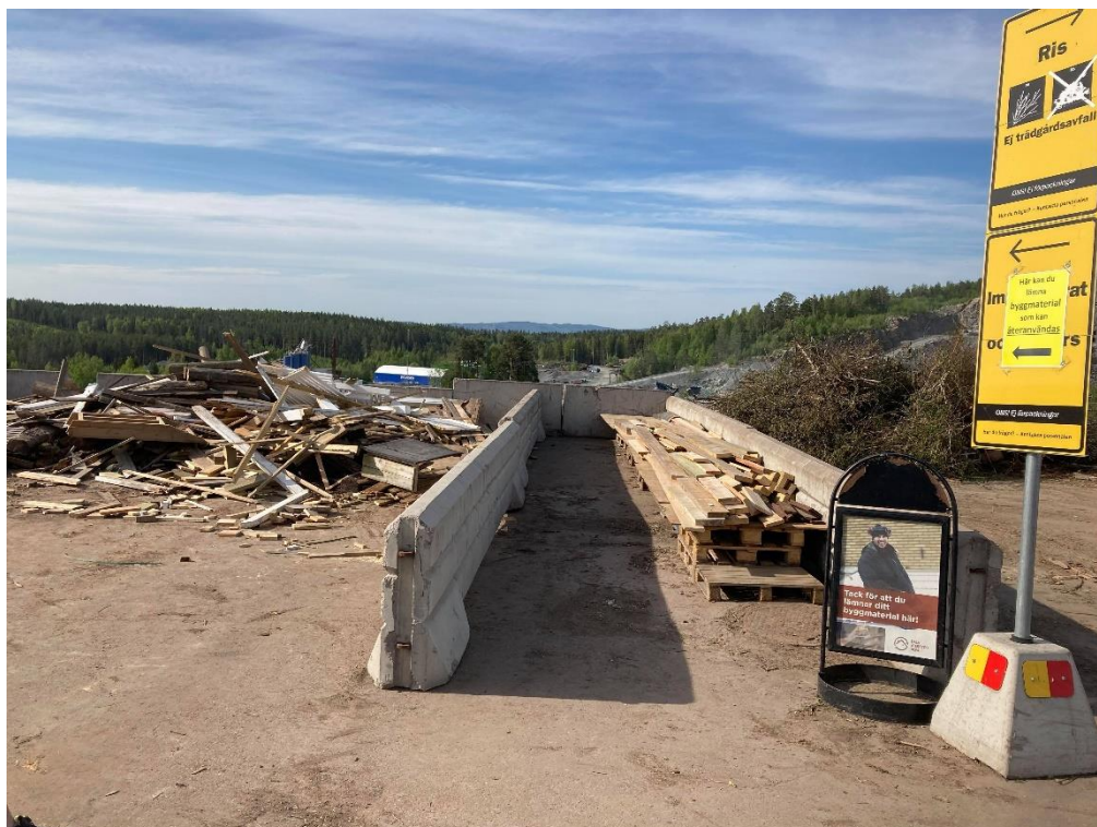
Figur 15. Fotografi över Fågelmýra återvinningscentral's initiativ att etablera en ytterligare fícka avsedd för insamling av återbrukbart byggmaterial. Källa: Sara Johansson.
