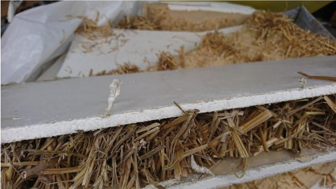
Figur 8. Närbild på den prefabricerade konstruktionen som består av gipsskiva, träregel och halm som isoleringsmaterial mellan gipsskivorna.
