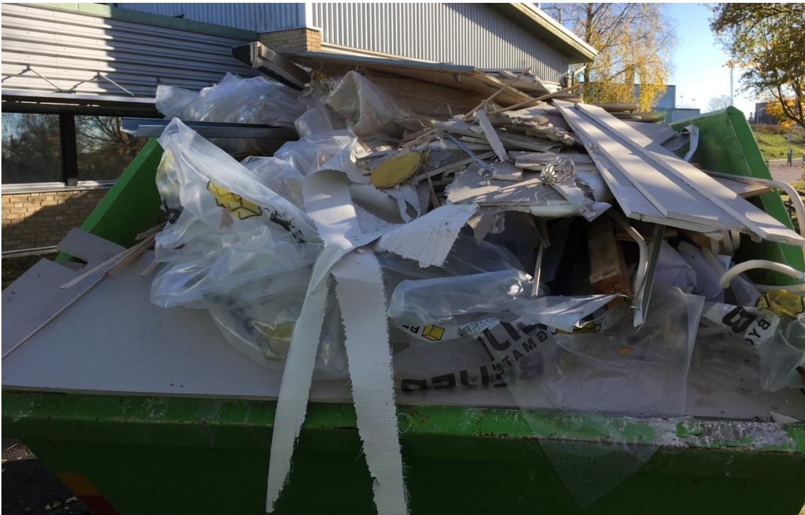
Figur 6. Gipsskivor i container för sorterat avfall.
