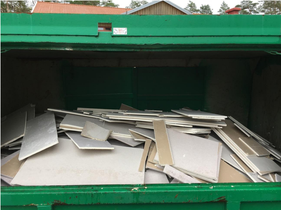
Figur 2. Spillbitar från montering av gipsskivor vid en nybyggnation.
