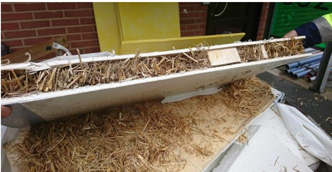
Figur 7. Prefabricerad väggkonstruktion som revs ut vid renoveringen.
