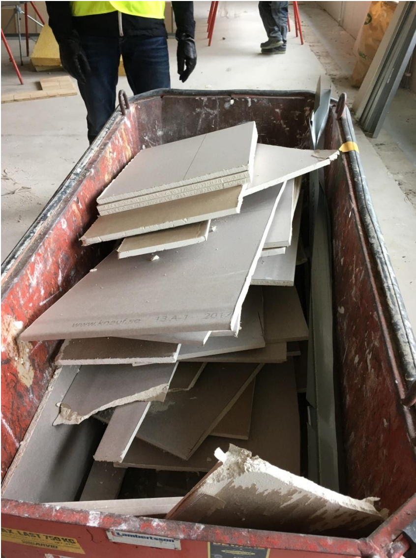
Figur 4. Spillbitar från montage av gipsskivor vid nybyggnation.
