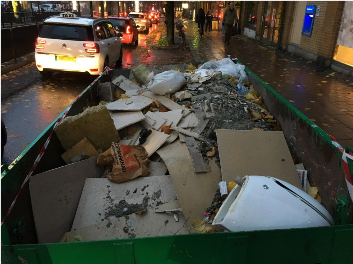
Figur 5. Gipsskivor i container för fyllnadsmassor.
