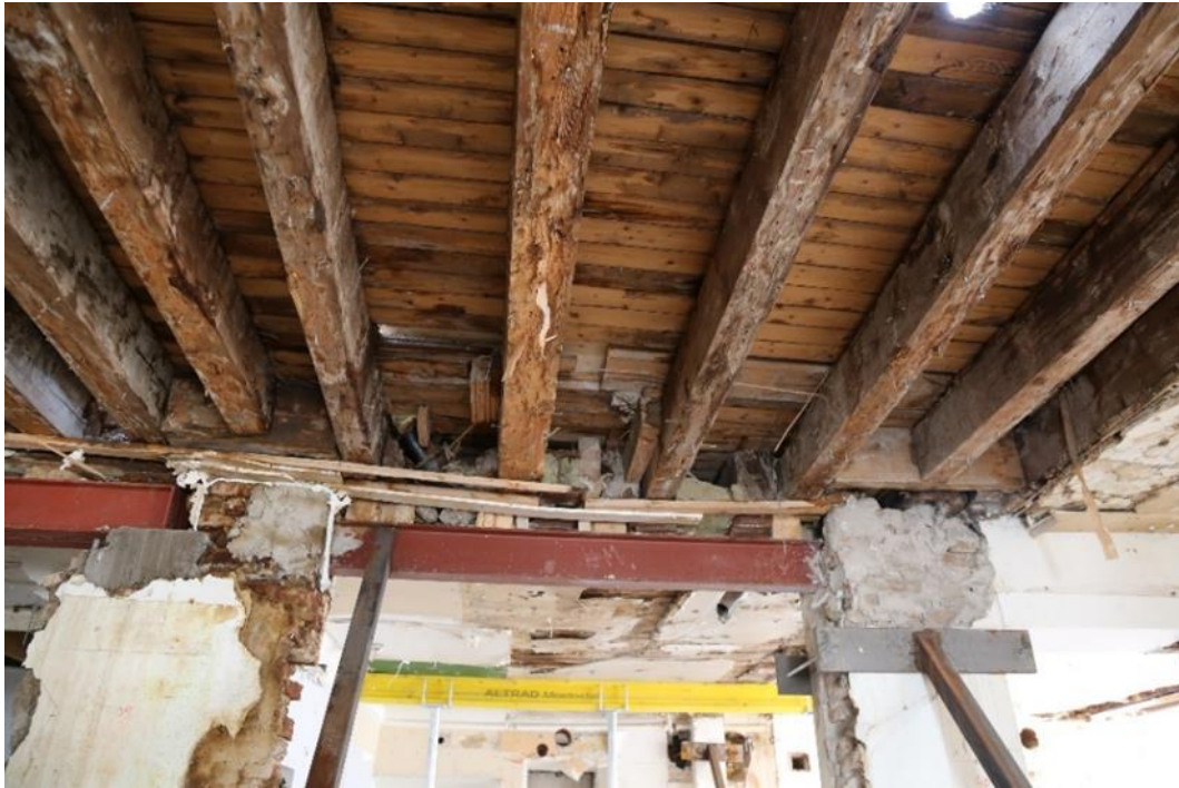
Figur 10 Detaljbild från våning 3. Äldre bjälklag i trä.
