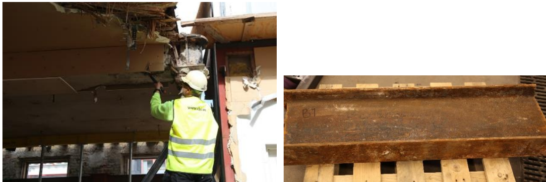
Figur 18 Balk B1. Balkens läge i byggnaden (t.v.) och den kapade sektionen som RISE hämtat till laboratoriet i Borås för analyser och provningar (t.h.). Sektionens mått: 300*125*760 mm.
