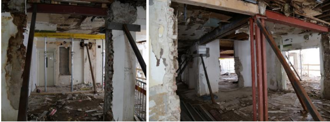
Figur 7 Interiör översiktsbild från våning 3. Notera speciellt bärande stålpelare och balkar, såväl nyare från 1970-talet (rödmålade) som äldre (rostbruna, omålade).
