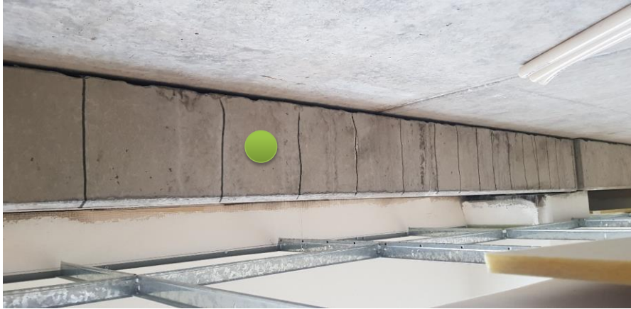
Figur 40 Balk med armeringsbyglar markerade med svarta streck (identifierade med georadar). Plats för uttagning av betongkärna är markerad med gulgrön cirkel.
