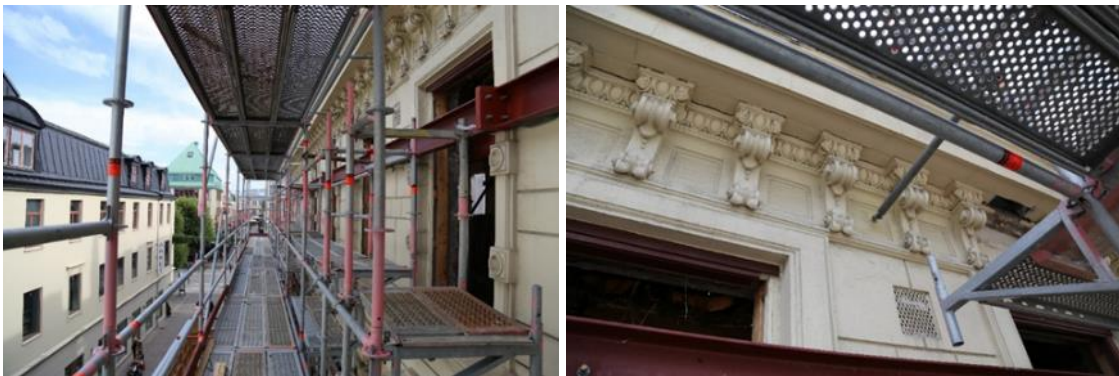
Figur 5 Översiktsbilder på norra fasaden (mot Kungsgatan). Denna fasad ska sparas.
