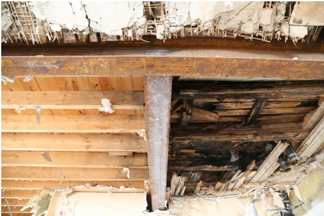
Figur 8 Detaljbild från våning 3. Äldre bärande konstruktion i stål och bjälklag i trä.
