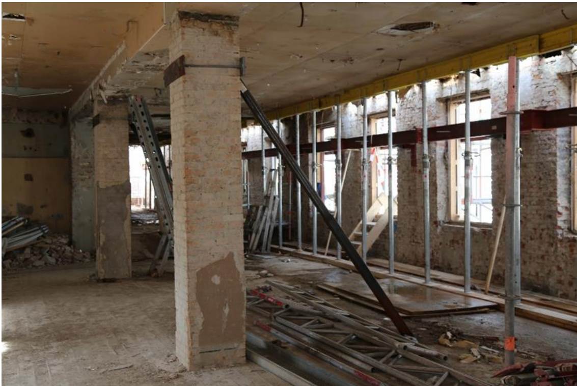
Figur 6 Interiör översiktsbild från våning 3. Notera speciellt bärande tegelpelare och ytterväggar i tegel.
