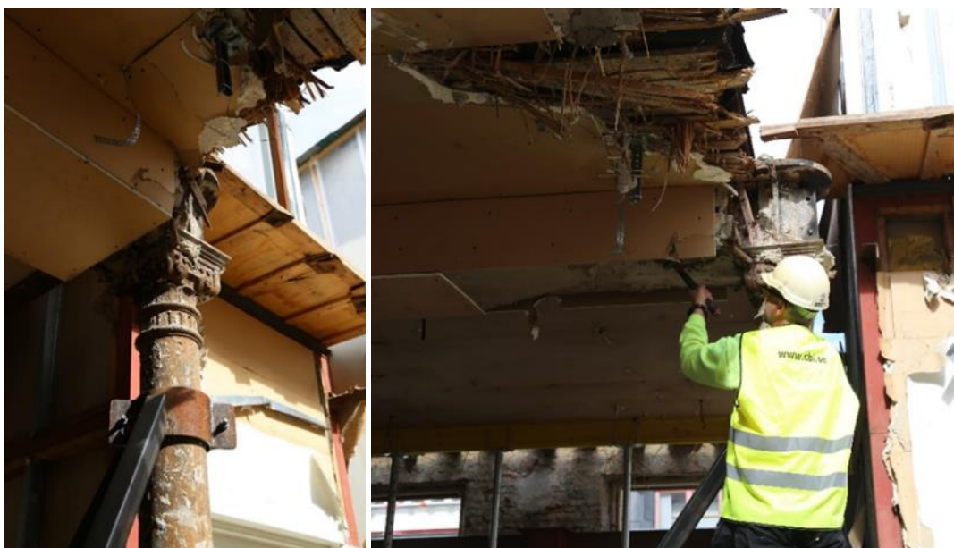
Figur 11 Inventering av pelare (t.v.) och balk (t.h.) och bedömning av okulärt skick.
