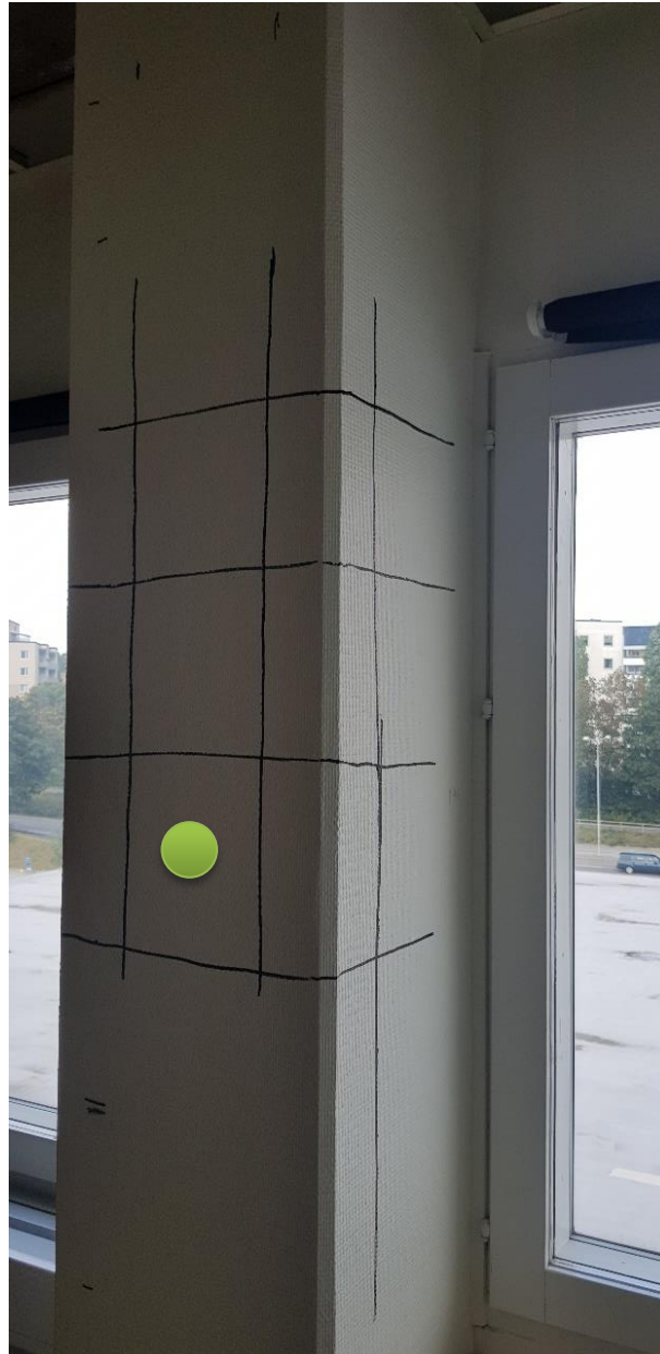
Figur 39 En pelare där stående armeringsstänger och liggande byglar har markerats med svarta streck (kartlagt med georadar). Plats för uttagning av betongkärna är markerad med gulgrön cirkel.
