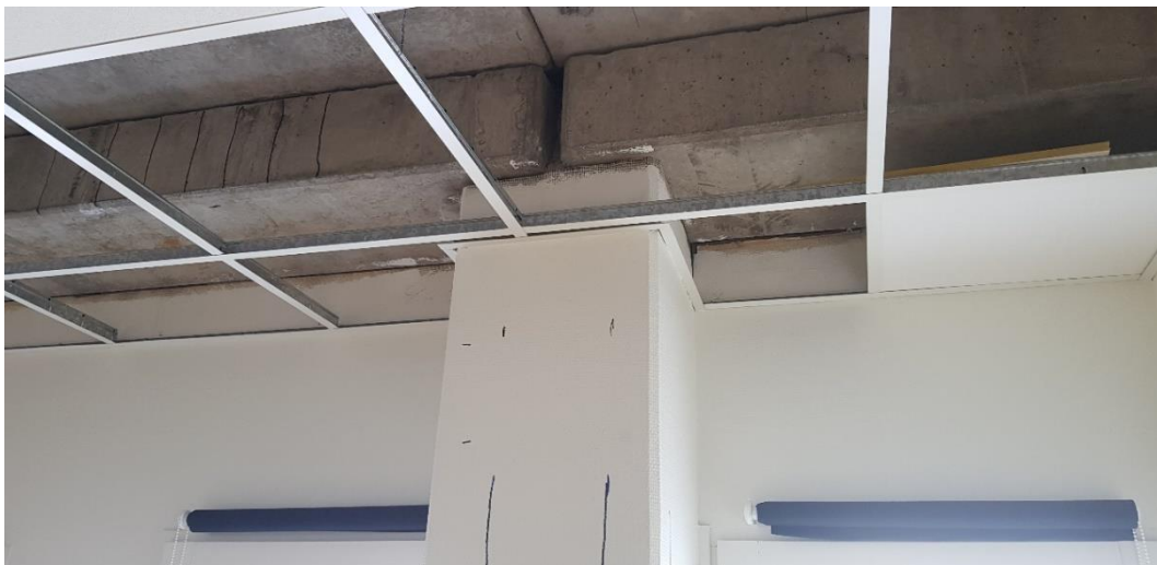
Figur 43 Utformning av upplag för balk ovanför pelartoppen.
