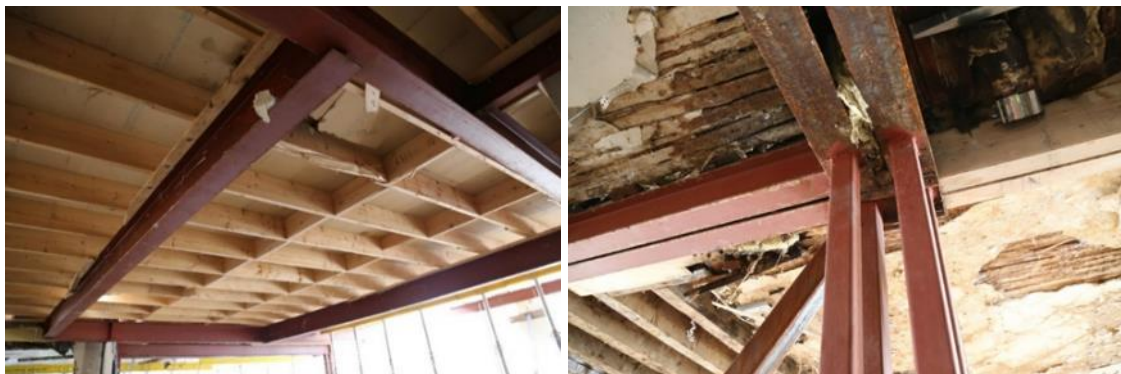
Figur 9 Detaljbild från våning 3. Nyare (1970-tal) bärande konstruktion i stål och bjälklag i trä.
